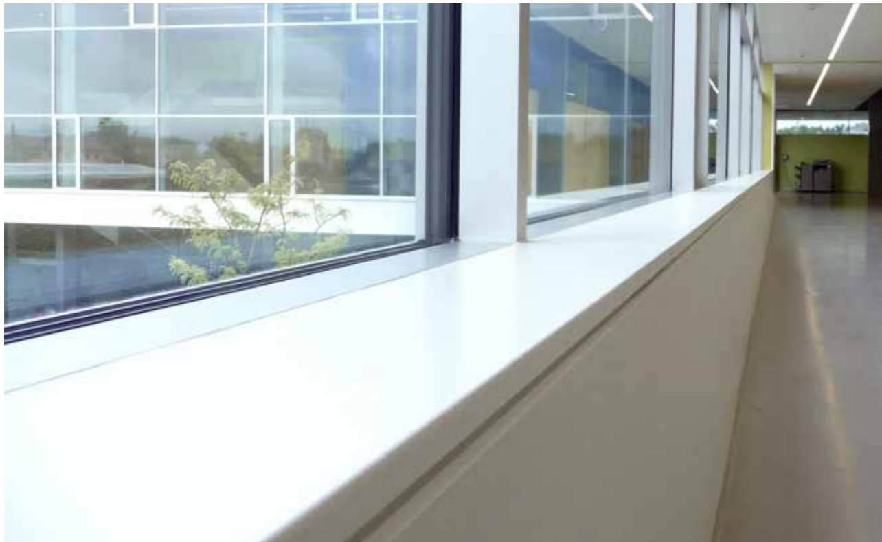
stumpfe Anbindung mit Anschlussprofil
