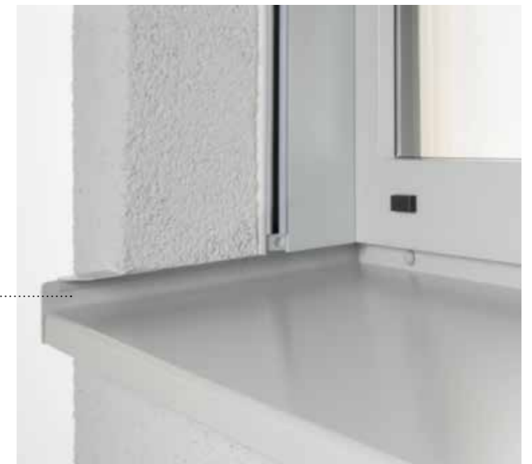
System SlideAlu-U für integrierte Sonnenschutz-Führungsschienen
